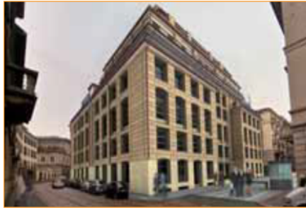
Condominio multifunzionale in Brera, Milano
